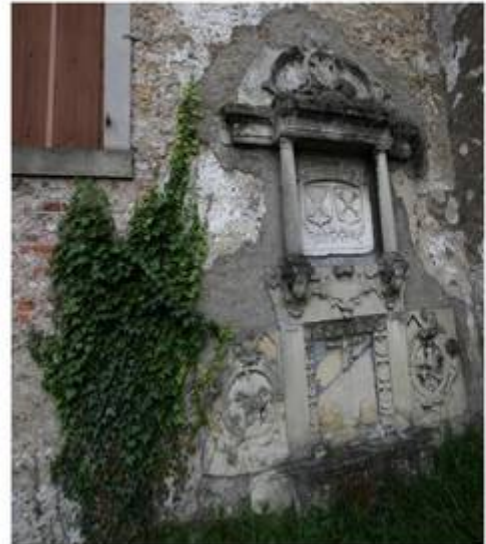
La tombe d'Andelan, le Seigneur de Morvillars, restera en façade.
