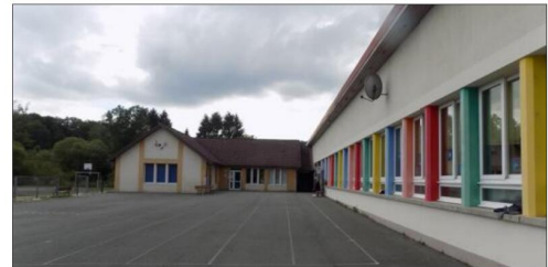
Le projet de rénovation de l'école est déjà bien engagé.
